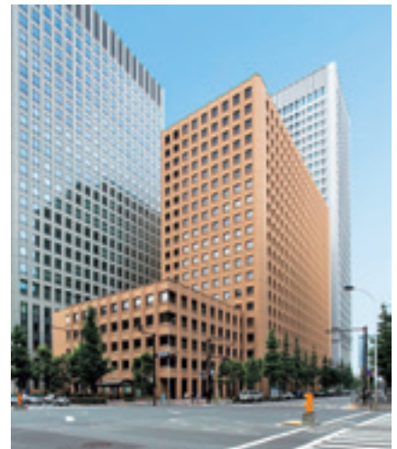
東京支店が入居している丸の内センタービルディング
